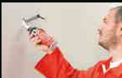
Riempimento di piccoli fori. Filling of small holes.
