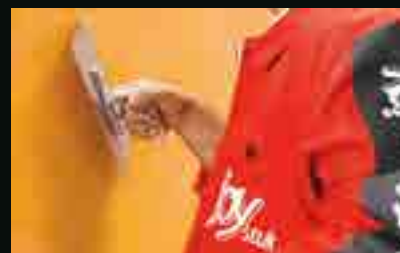
Finitura parete con stucco colorato. Wall finishing with coloured stucco.
