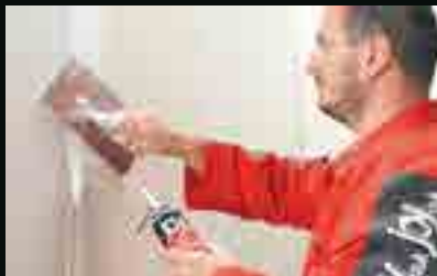
Rasatura immediata dopo l'applicazione del prodotto. Immediate smoothing after the product application.
